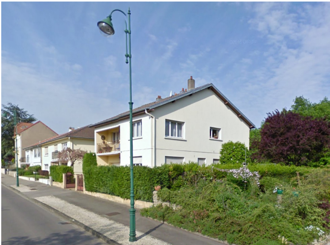
> Habitations situées à l'entrée ouest de la Grand' rue
