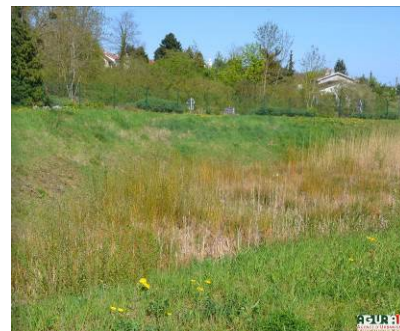
> Bassin de rétention des eaux pluviales, secteur Pré Dames Belles
