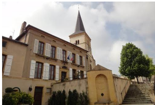
> Les équipements structurants du cœur historique de Lorry-Lès-Metz
