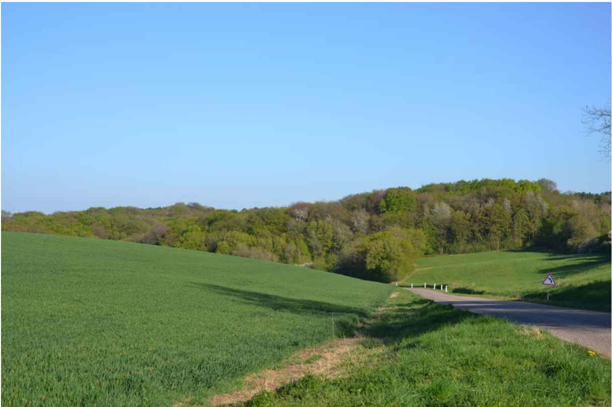
> Chemin improvisé et non sécurisé le long de la RD51 entre Lorry-lès-Metz et Amanvillers
