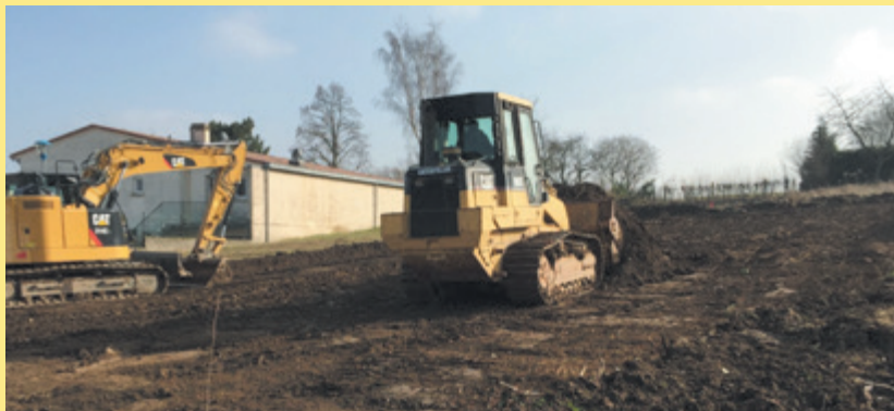
Décapage des terres végétales du parking et de la base chantier le 13 février 2017.
