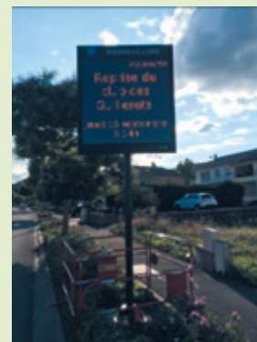
Panneau LUMIPLAN HD en cours de pose à Pierrevillers (septembre 2015)
