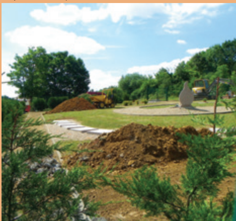
Travaux au cimetière.
