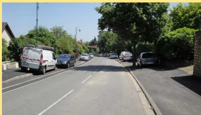
La Grand'Rue après les travaux...
